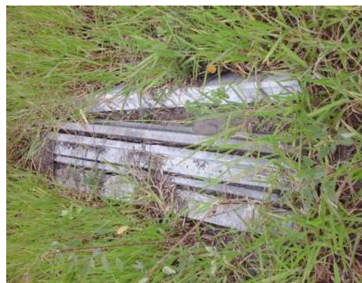
Figura 03 – Estacas de concreto depositadas no canteiro.
