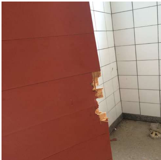
Porta sem fechadura
