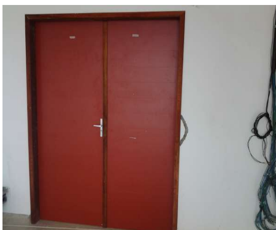
Figura 01 – Porta com fechadura Foto do fiscal – 2014
