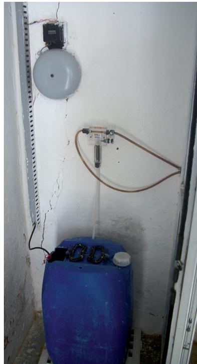
Figura 4.18 - Dosador automático de cloro, que abastece todas as caixas d'água.
