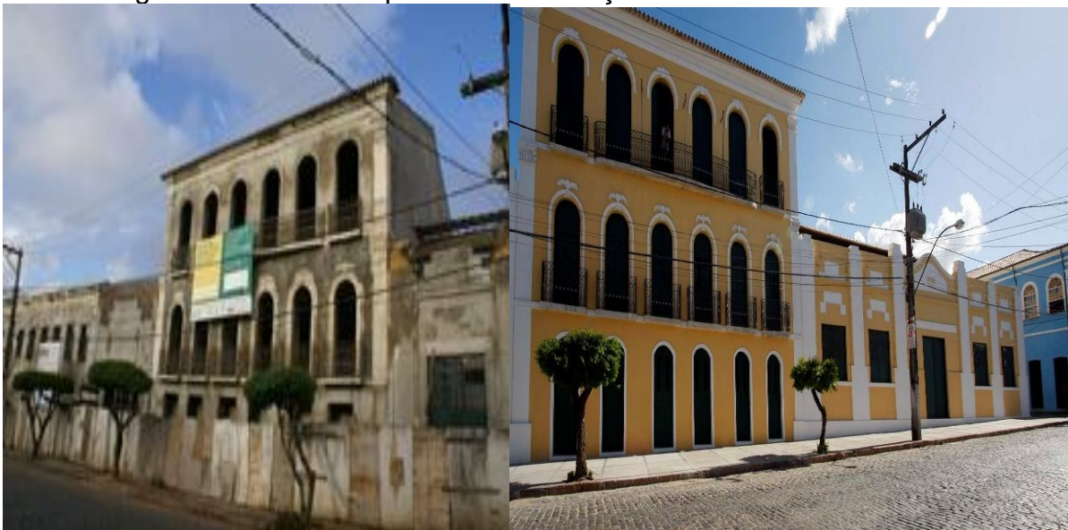
Figura 10: Antes e depois da Restauração do Quarteirão Leite Alves
