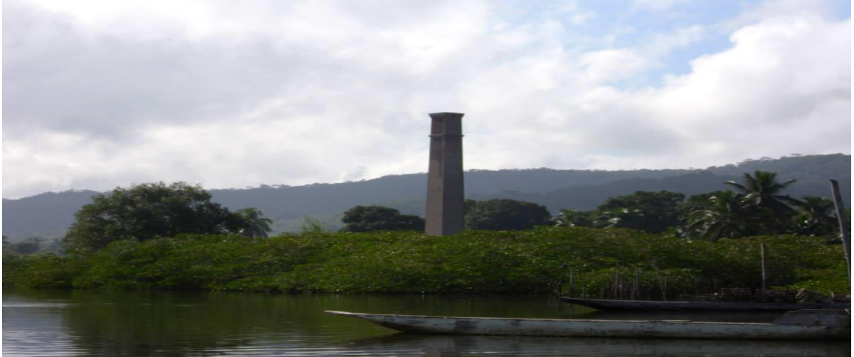
Fotografia 1 - Torre do engenho central do Iguape, 2013.
