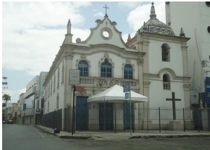
Figura 6 - Igreja dos Remédios
