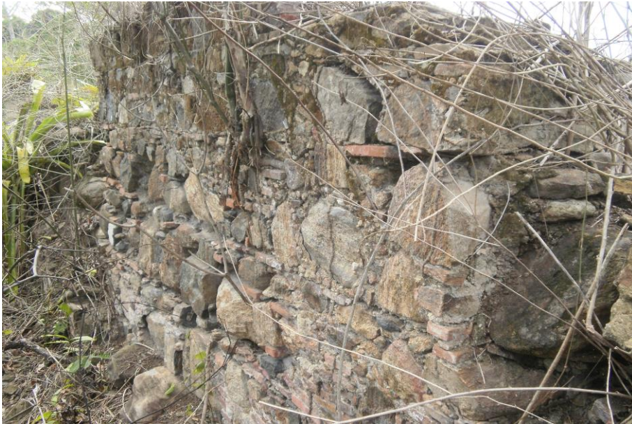
Fotografia 5 – Parede da casa de moagem
