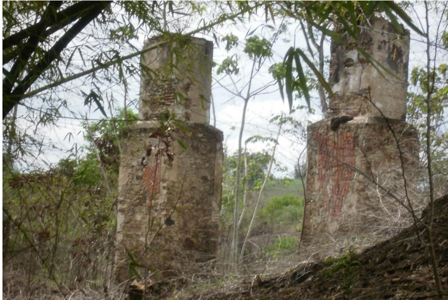
Fotografia 3 – Pilastras da casa de moagem
