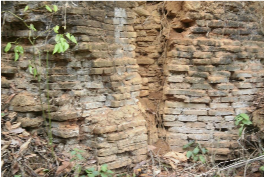
Fotografia 1 – Parte da estrutura de barramento 27
