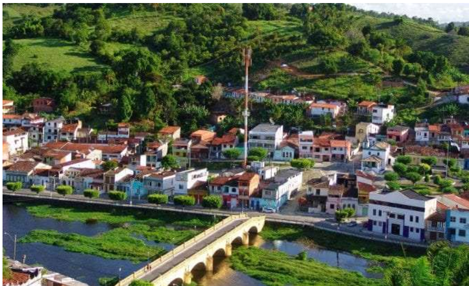
FIGURA 05 – Ponte sobre o Rio Jaguaripe que atravessa a cidade FONTE: http://www.nazare.ba.gov.br . (Acesso 2019).
