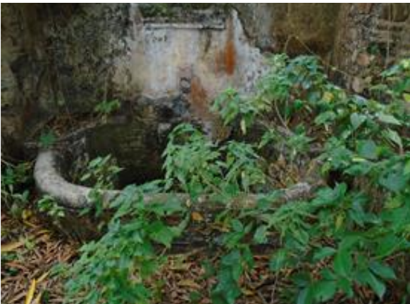
Figura 06: Antiga fonte do Engenho Vitória em estado de deterioração.
