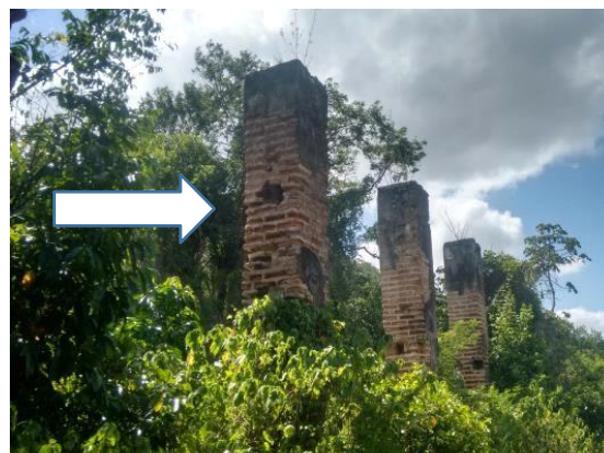
Figura 28: Colunas de sustentação do telhado do espaço fabril do Engenho Vitória.
