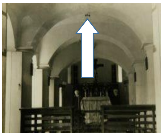
Figura 33: Teto abobado da antiga capela do Engenho Vitória.
