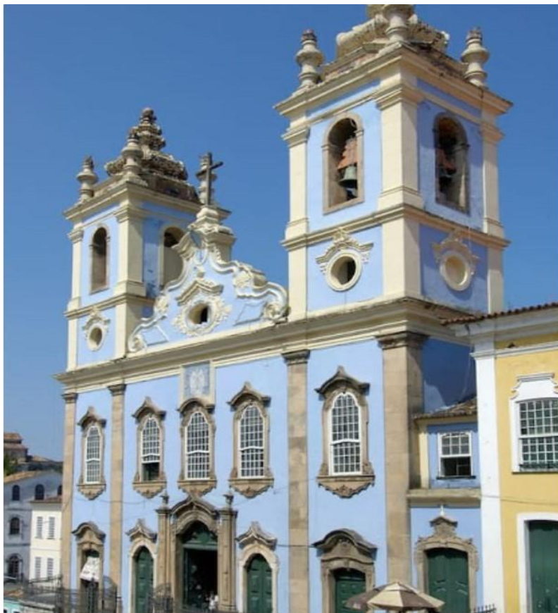
Figura 2 – Igreja de Nossa Senhora dos Rosários dos Pretos
