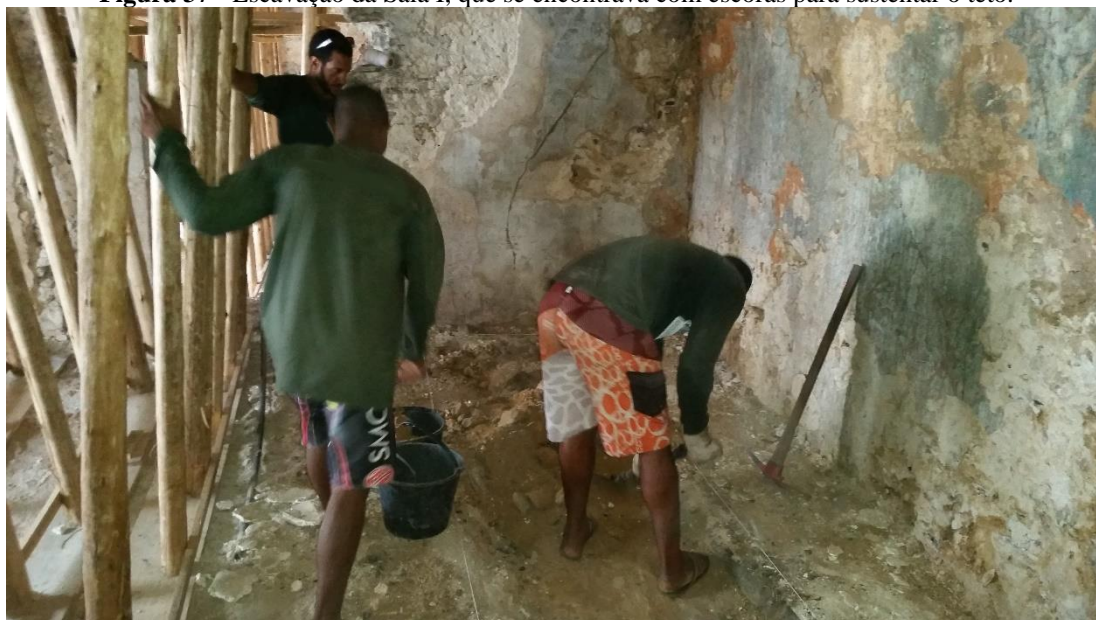
Figura 37 - Escavação da Sala I, que se encontrava com escoras para sustentar o teto.
