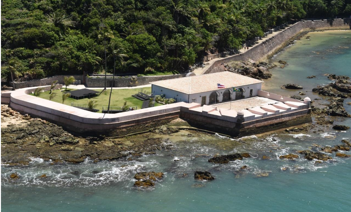
Figura 36 - Vista da Fortaleza do Morro de São Paulo, após as obras de restauração.
