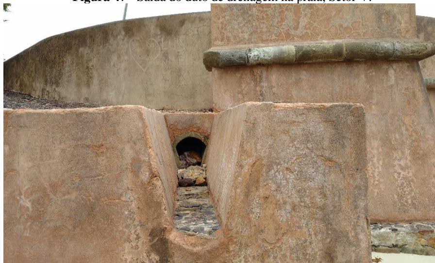
Figura 47 - Saída do duto de drenagem na praia, Setor V.
