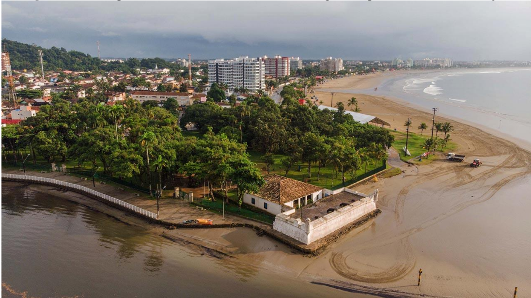
Figura 11 - Vista panorâmica do Forte São João de Bertioga-SP, após as obras de restauração.
