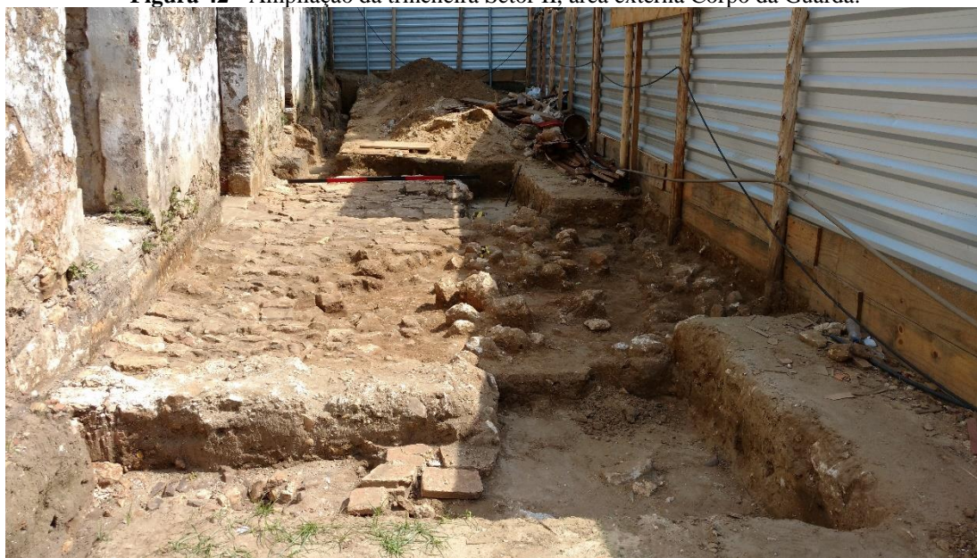
Figura 42 - Ampliação da trincheira Setor II, área externa Corpo da Guarda.
