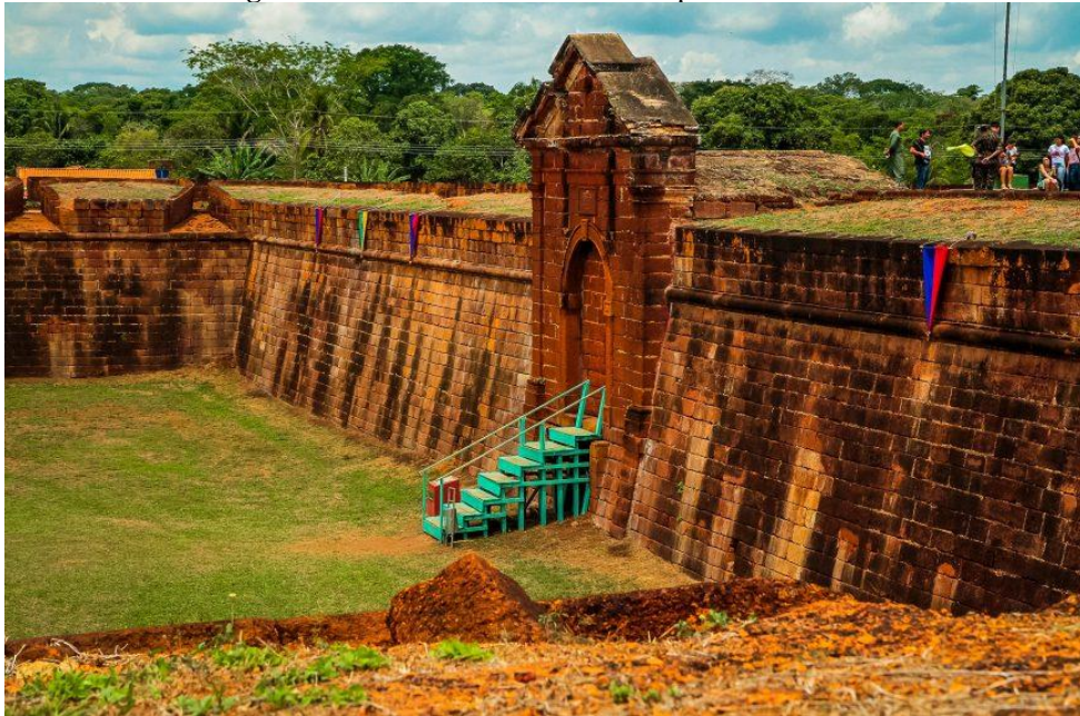
Figura 14 - Vista do Real Forte Príncipe da Beira-RO.
