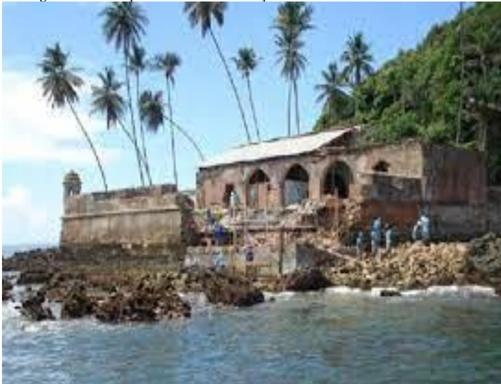
Figura 35 - Execução das obras de restauração da Fortaleza do Morro de São Paulo.
