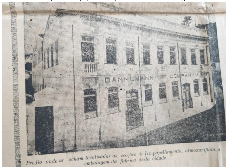
Figura 05: Prédio com seções de empapelamento, almoxarifado e embalagem Dannemann
