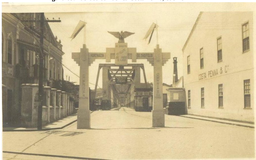
Figura 09: Fachada da Fábrica Costa Penna, São Félix
