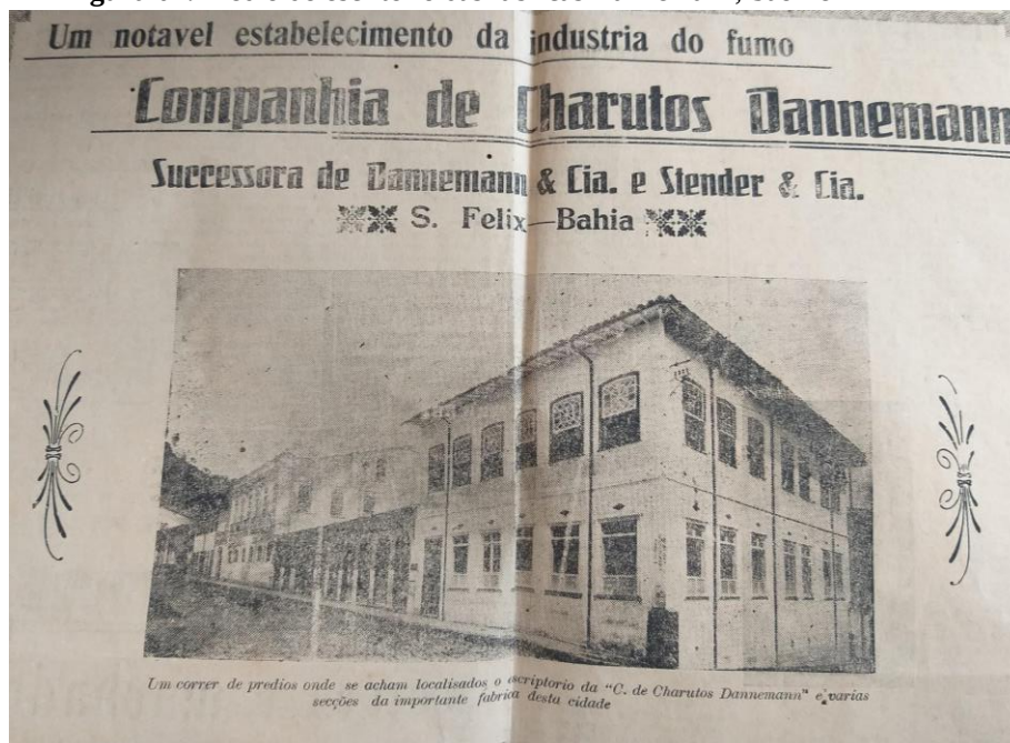
Figura 04: Prédio do escritório das fábricas Dannemann, São Félix
