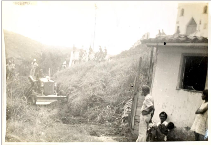
Figura 6 – Construção da subida da ladeira do Cucui
