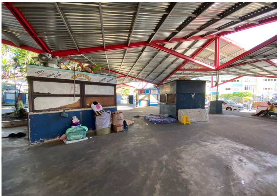
Figura 2 – Foto da área interna do Terminal Aquidabã
